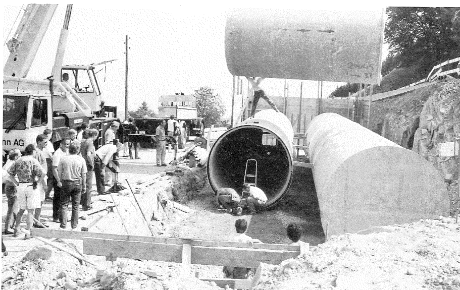
Abb. 3 Versetzen des Elementes (8 t) mit Autokran
