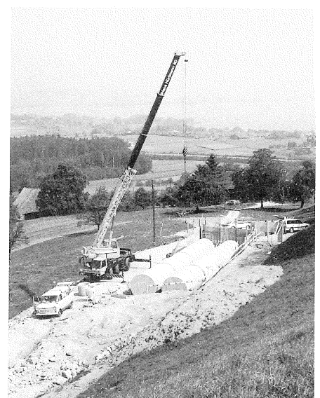
Abb. 4 Versetzte und montierte Röhrenbehälter
