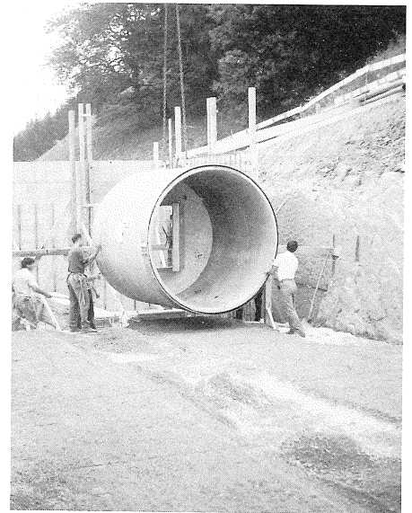
Abb. 2 Versetzen des 1. Elementes an Ort
