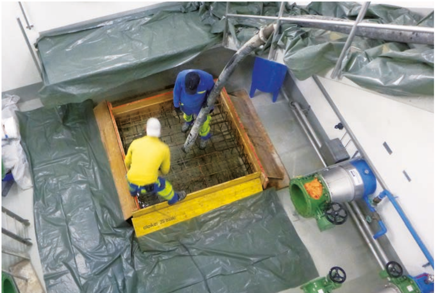
Betonieren neuer Pumpensockel
