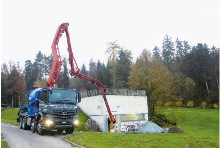
Betonpumpe für Betonierarbeiten Reservoir Bachtalen
