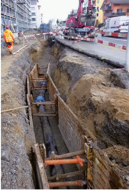
Leitungsbau entlang Luzernerstrasse
